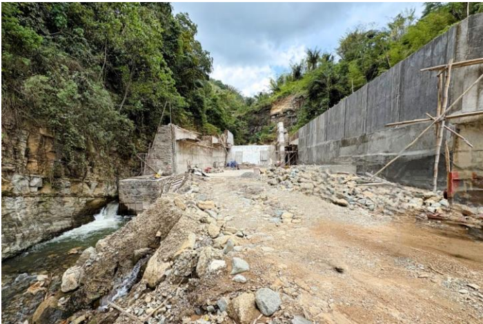
写真 小水力発電(工事中)
