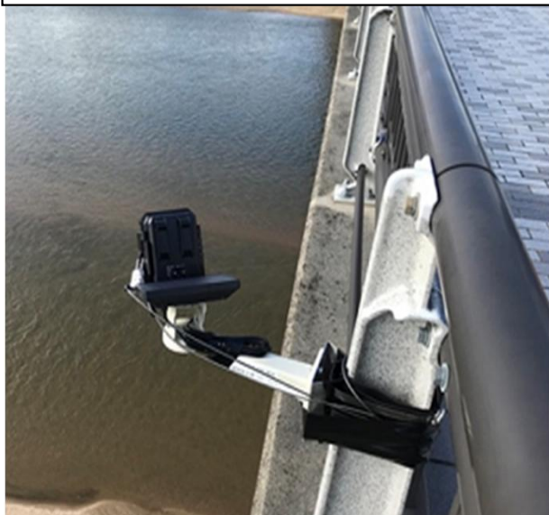
カメラの設置状況（木津川）
