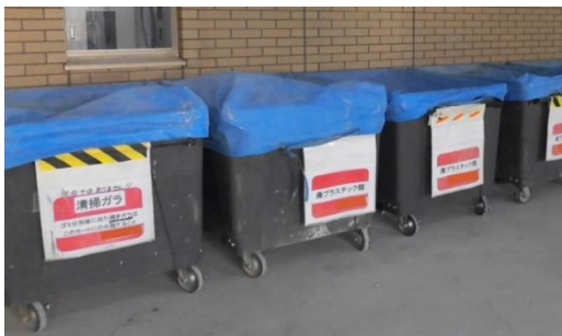
図 5-5 建設廃棄物の現場における分別の例
