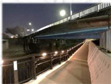
狭山池橋下アンダーパス
