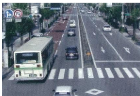
図 4-5-2 バス優先レーンの設置 出典：大阪府警察本部 ホームページ
