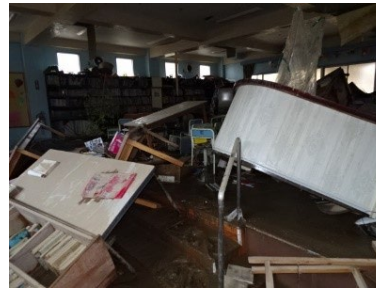
令和2年7月豪雨の被害
