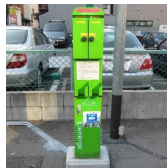
図 4 - 3 - 2 電気自動車の充電設備
