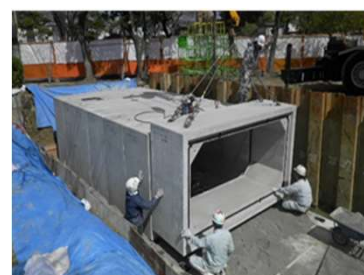
校庭の地下への雨水貯留槽の設置
