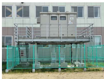
架台の設置による受変電設備への 浸水対策
