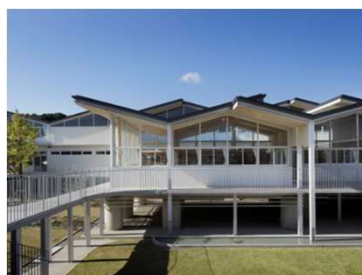
高床化による校舎への浸水対策
