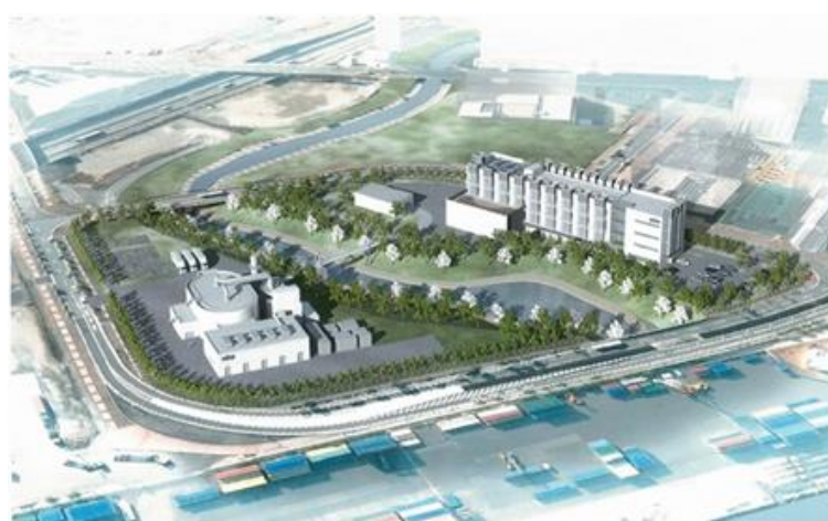
大阪市咲洲地区に整備された 大型蓄電池試験・評価施設
