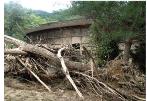
2018年7月豪雨による被害(能勢町)
