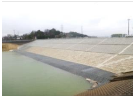
老朽ため池の改修
