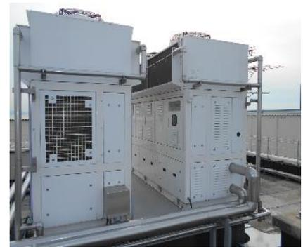
CO<sub>2</sub>冷媒冷凍機 (舞洲物流センター)② CO<sub>2</sub>冷媒冷凍機の採用
