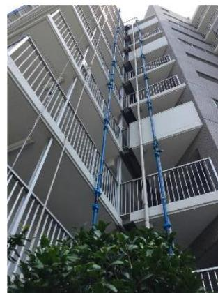
集合住宅での経年給水管の布設替え工事に伴う仮設配管例
