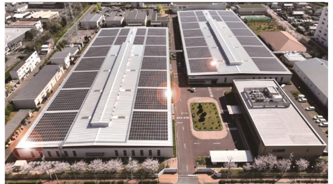
本社工場屋根に設置の太陽光発電設備
