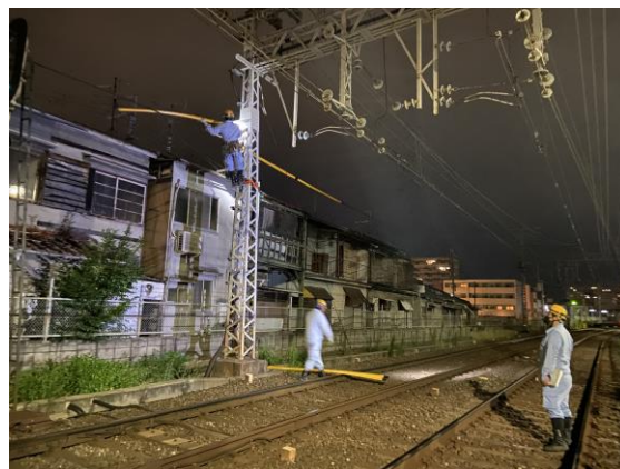
鉄道施設移設
