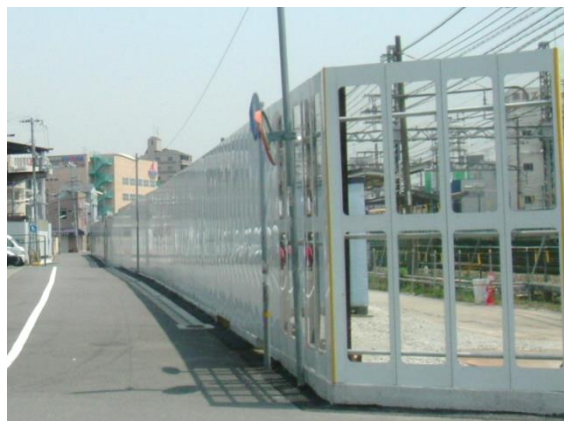
仮囲いフェンス設置
