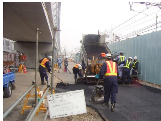
工事用進入路整備
