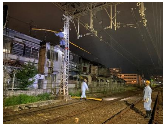
鉄道施設移設
