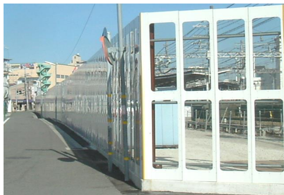
仮囲いフェンス設置
