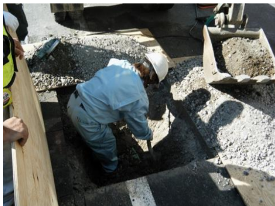
埋設物試掘調査
