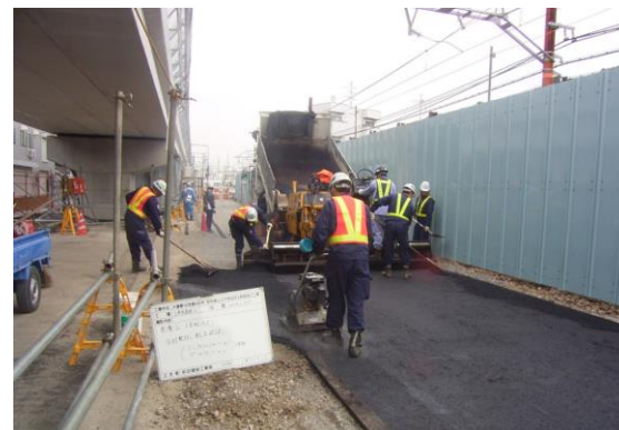
工事用進入路整備
