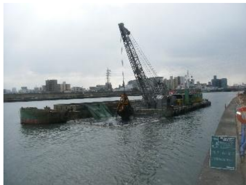
神崎川河床掘削工事
