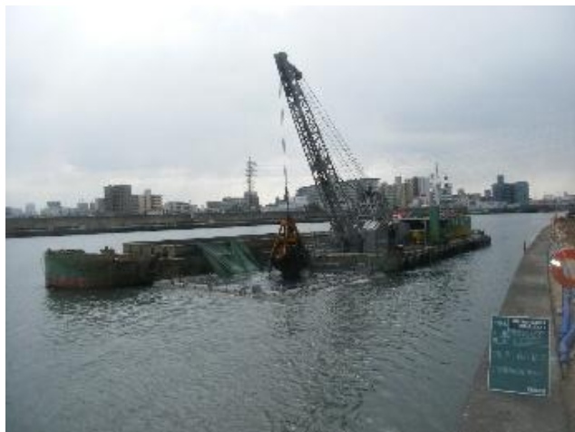
神崎川河床掘削工事
