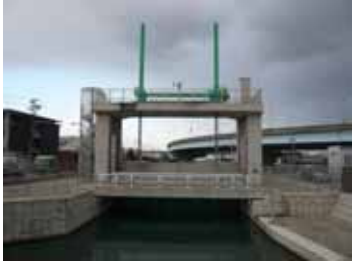
古川水門(施工中)
