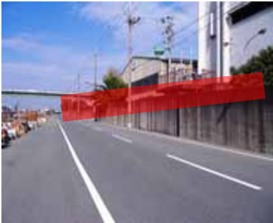
胸壁改良(未施工)
