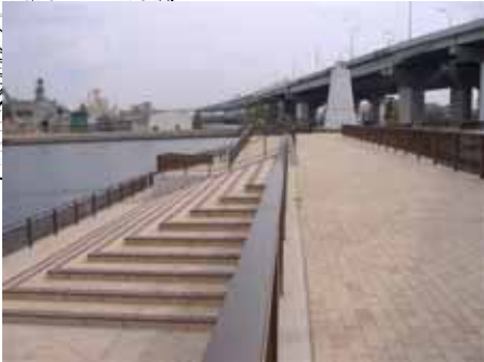
護岸改良(施工中)
