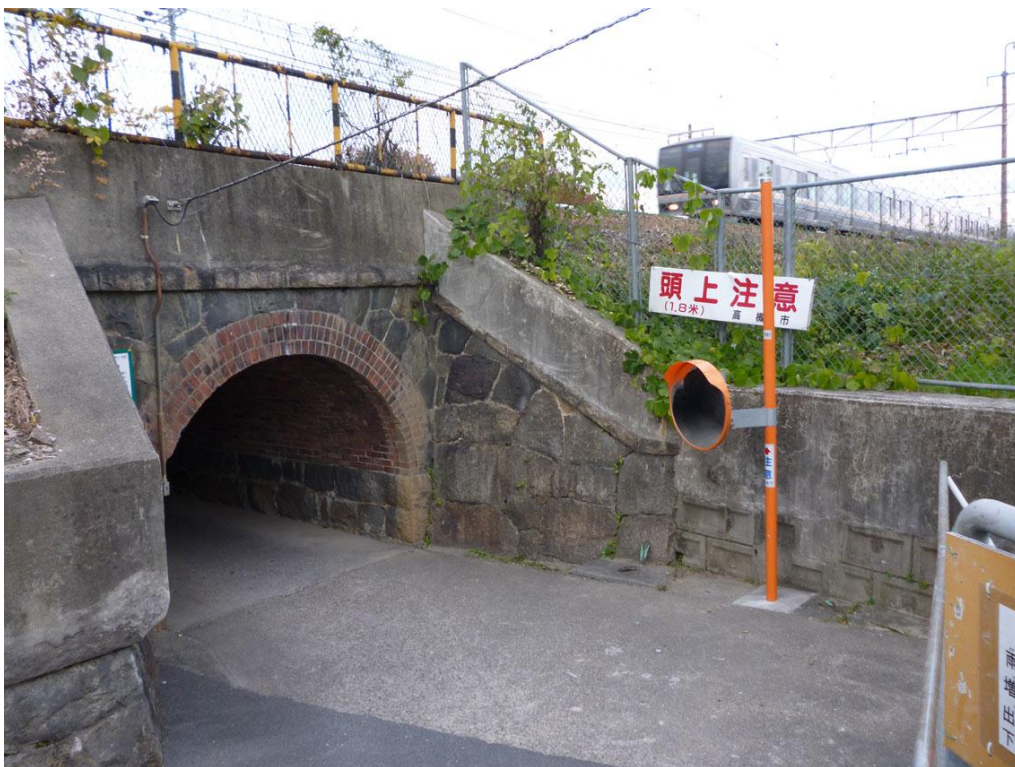
JRのガードに高槻城の石垣の石が転用されています。
