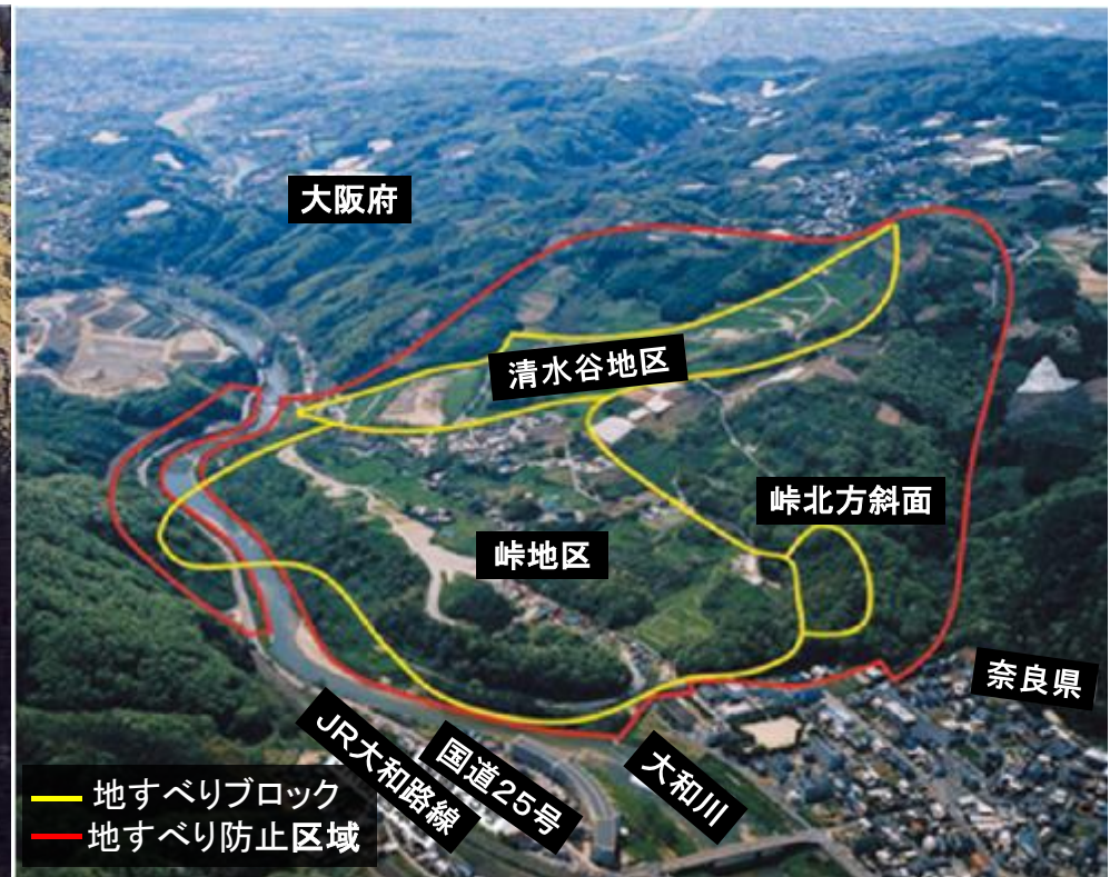
柏原市 亀の瀬地区
