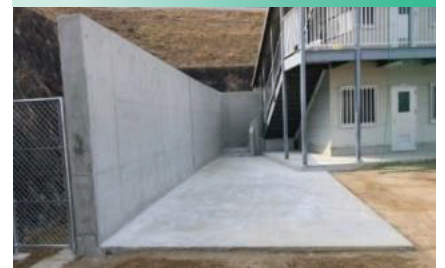
防護壁を設置し、土砂の流入による建物被害を防ぐ
