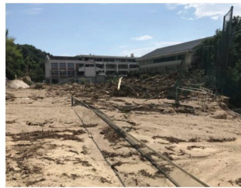
平成30年7月豪雨 建物への土砂流入
