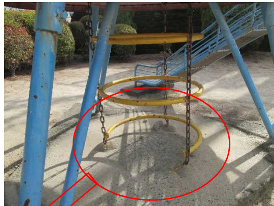
コンクリートの露出状況
