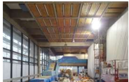
写真 ー 高層棟ロビーの特定天井の改修工事
