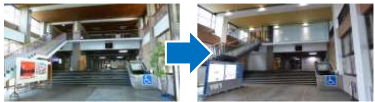
写真一正面玄関の特定天井の改修（左：改修前、右：改修後）
