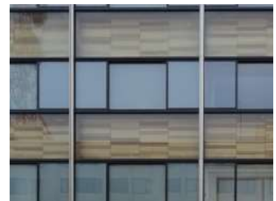
写真一道路側の外壁改修
