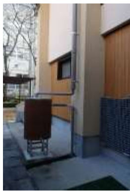
写真—雨水タンク
