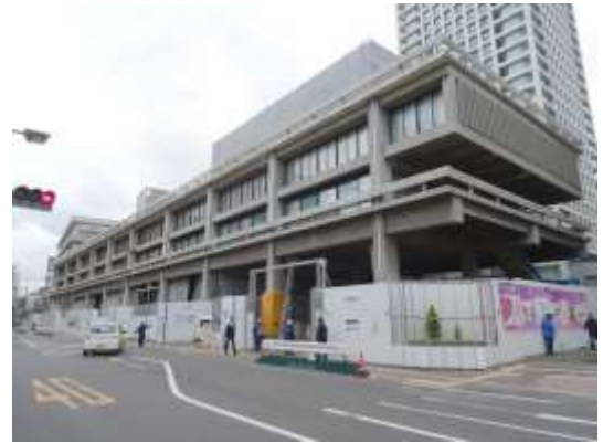
写真 — 改修工事中の香川県庁舎東館（低層棟）
