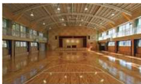
写真—アリーナの天井改修
