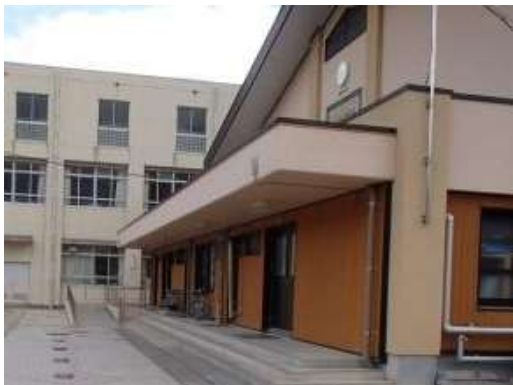
写真—改修後の体育館
