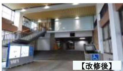
写真一 正面玄関の特定天井の改修
