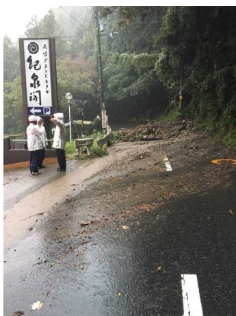
崖崩（通行止め）
