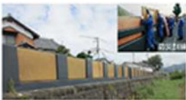
自主防災活動による畳堤設置 (樺太川水系、たつの市)
