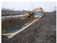
河道掘削 (石狩川水系、北海道開発局)
