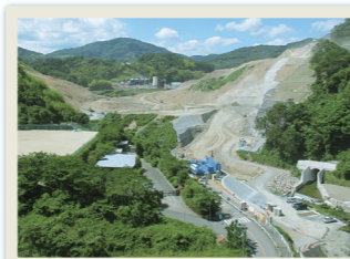
2016年6月の建設現場
