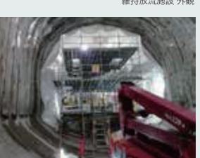
監査廊: ダム堤体の下部に設置する点検用の地下通路。堤体及び基礎岩盤内の浸透水計測や地震観測等を行います。
