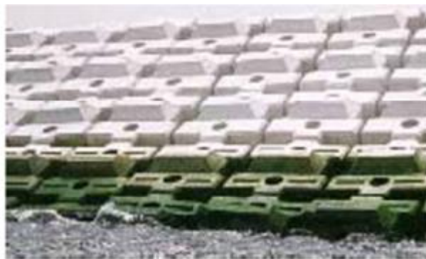
図 44 大阪沖埋立処分場の緩傾斜護岸
