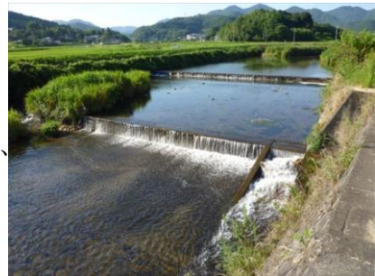
河川に設置された魚道(大路次川)
