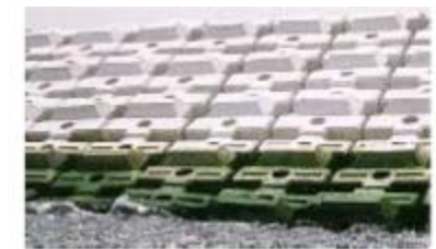
図 6 大阪沖埋立処分場の緩傾斜護岸
