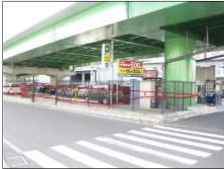
国道170号新町跨 道橋高架下 (東大阪市)
