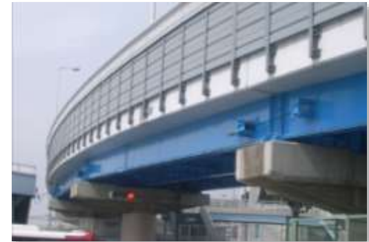
落橋防止対策
