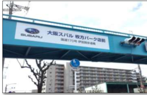
一般国道170号 伊加賀歩道橋(枚方市)
