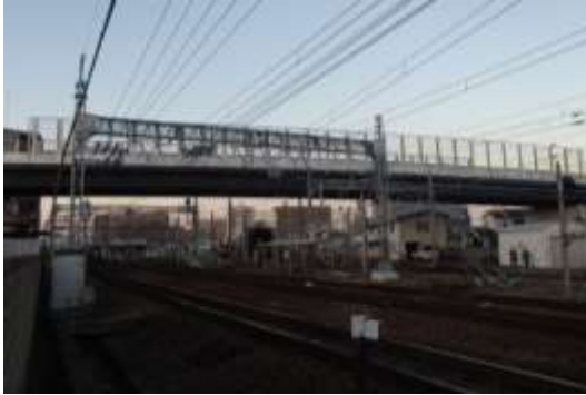
道路と鉄道の立体交差化 (〔都〕堺港大堀線・松原市)
