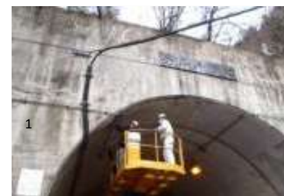
〔トンネル点検〕
