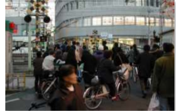
高架化前の混雑状況 (京阪本線・香里園駅付近・寝屋川市)
