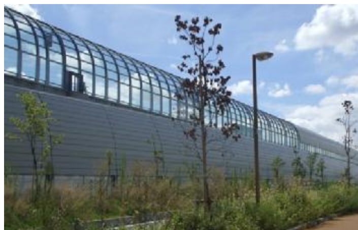
遮音壁の設置
