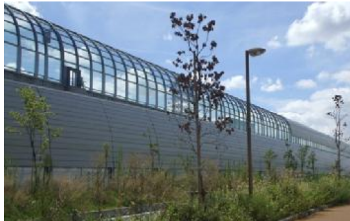
遮音壁の設置
