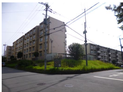
北東方より調査対象地
