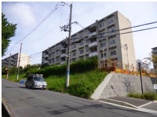
北西方より調査対象地
