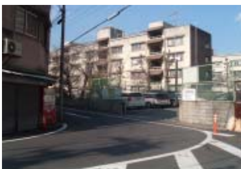
調査対象地南西方向
