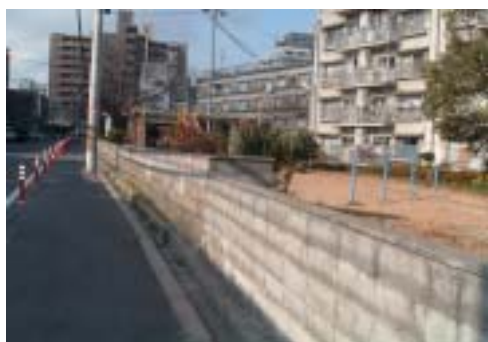
調査対象地南西方向
