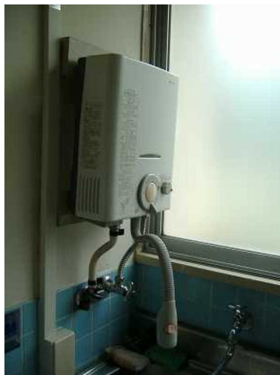
写真20 湯沸室 給湯器
