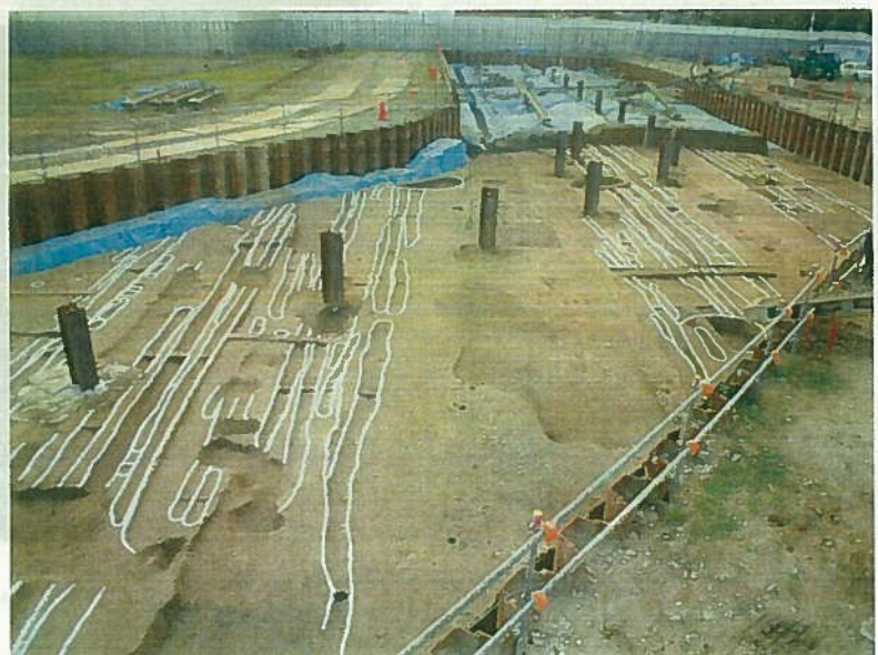
1 調査区東半 第3面 (東から)
