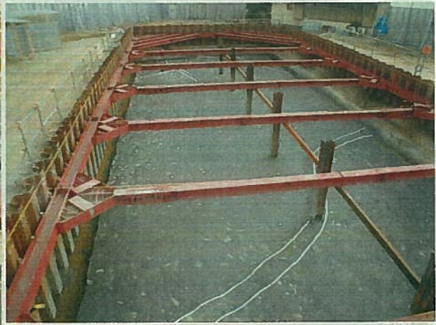
1調査区 第7面 東半（西から）
