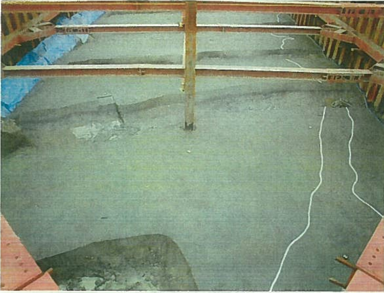
1 調査区 東半 14b面 (東から)
