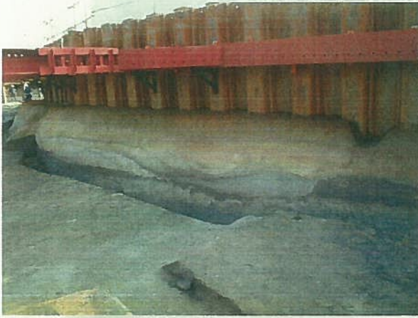
1 調査区 調査区断面 南壁 6 b層～7 b層
