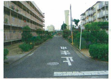
調査対象地-写真③ (北側から1本目 東側から西側を望む)
