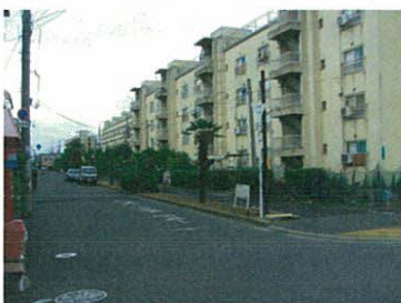
北側敷地境界付近-写真⑯ (西側から東側を望む)
