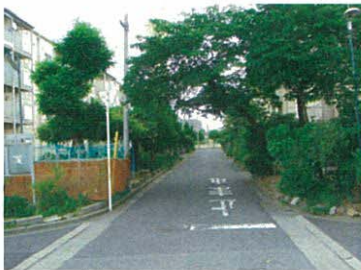
調査対象地-写真④ (北側から1本目 西側から東側を望む)
