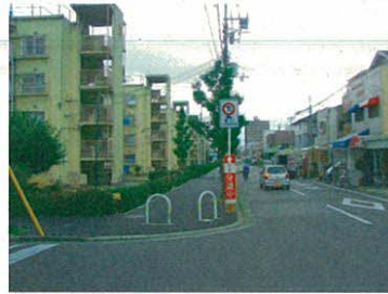
東側敷地境界付近-写真⑪ (南側から北側を望む)
