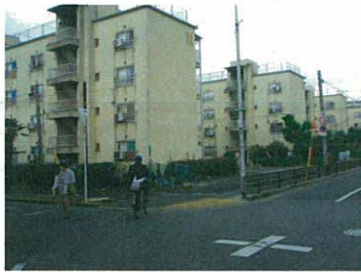
調査対象地-写真① (北西側から南東側を望む)
