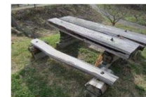
老朽化し危険な木製ベンチ
