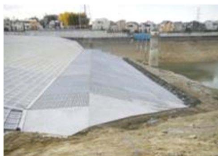
耐震補強工事（押え盛土）
