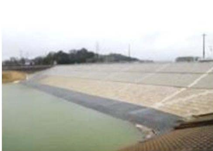
老朽ため池改修
