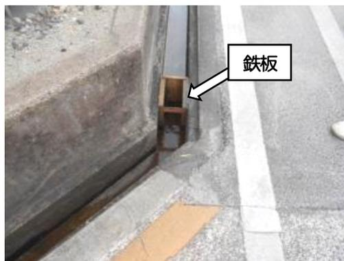
鉄板による排水溝の閉止
