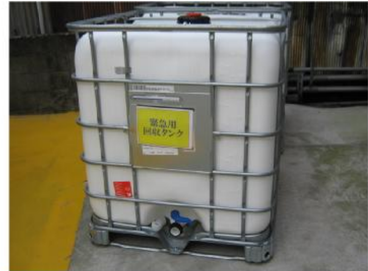
緊急用回収タンク
