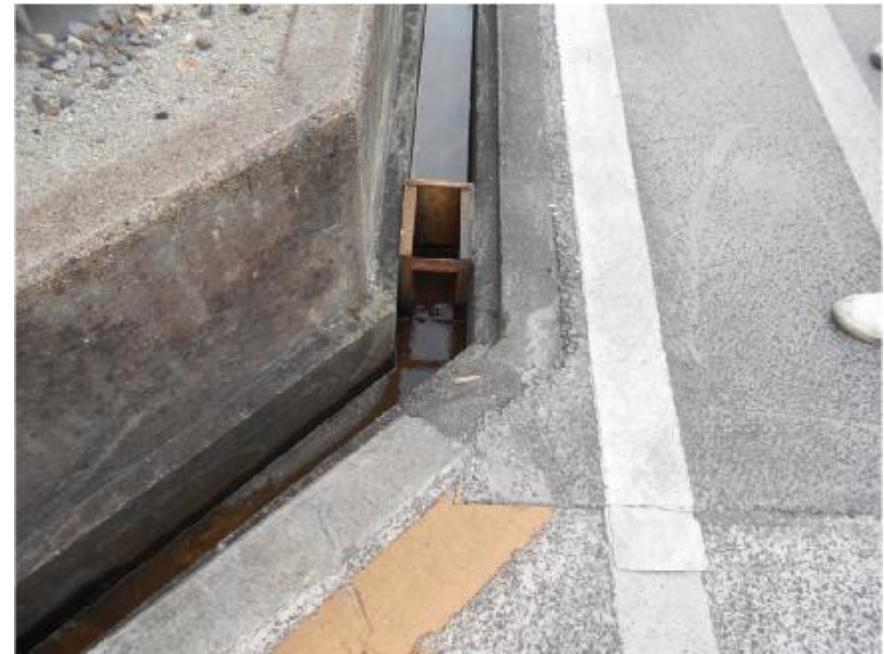
排水溝を閉止する金属板
