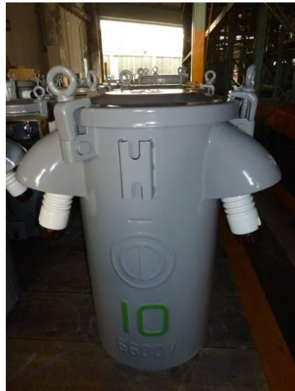
修理後の外観
