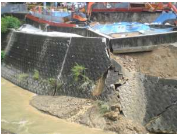
松尾川（箕形橋～唐国橋）
