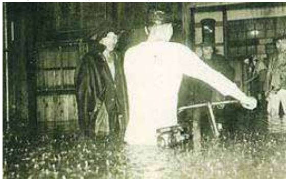
泉大津市役所玄関（泉大津市）
