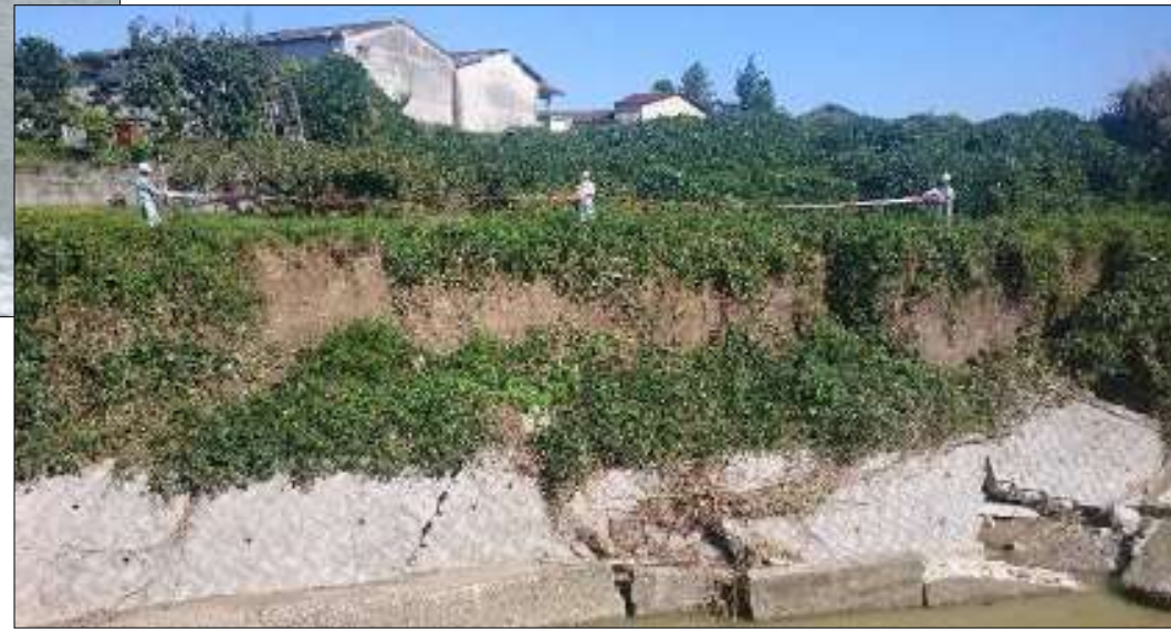
牛滝川上長滝橋上流右岸 (岸和田市山直中町)
