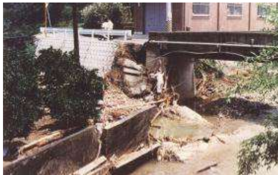
槇尾川地藏橋（和泉市坪井町）
