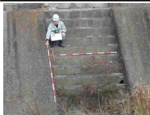
河川管理施設の点検
