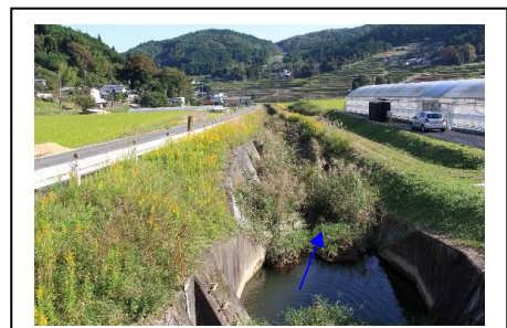
上流部(西田橋付近)
