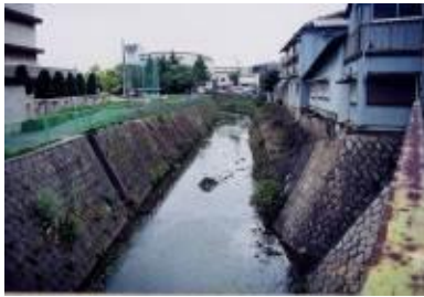
①大正川（春日橋下流）
