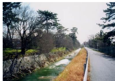
②高川（高川水路橋下流）
