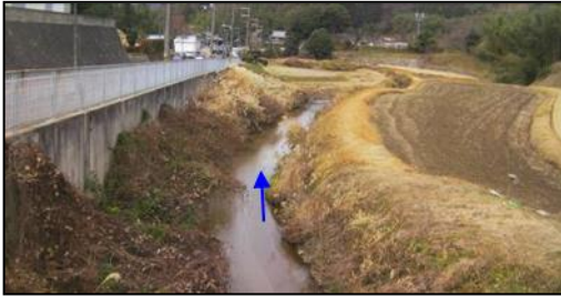
写真① 木代川（新木代橋下流部）
