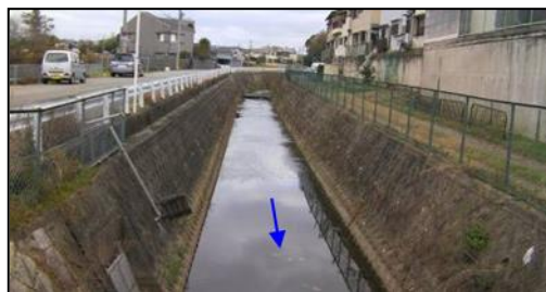
写真② 芋川 (西原橋上流部)
