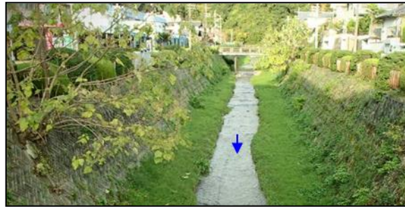
写真① ときわ大橋上流部
