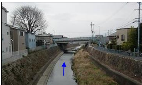
写真① 下流部（天神小橋下流部）
