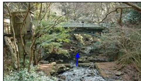
写真② 上流部（大門橋下流部）
