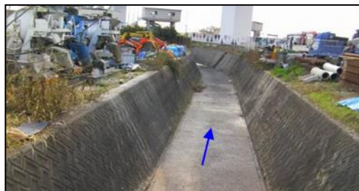
写真① 神田排水樋門上流
