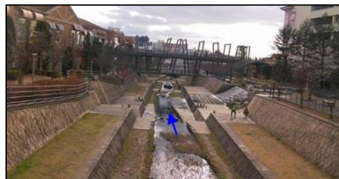
写真② 上流部 (萱野中央中橋下流部)
