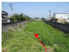
②一軒屋橋下流
