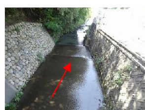
⑦8号無名橋下流
