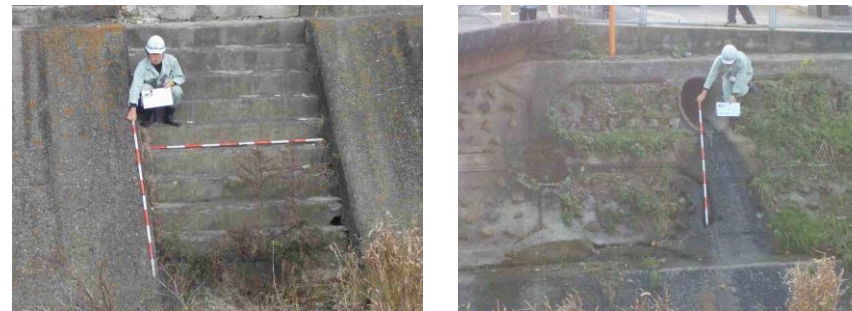
河川管理施設の点検
