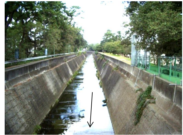
改修箇所写真(水路橋上流)
