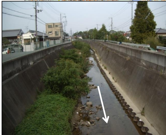
豊南橋から上流を見る
