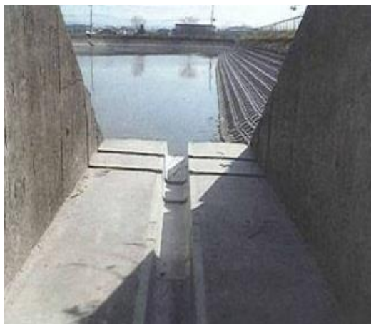
【治水容量の確保】 余水吐を溝状に切り下げることで、常時の水位を低下させます。（他府県事例）
