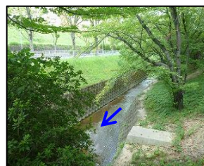
④ 無名橋より上流
