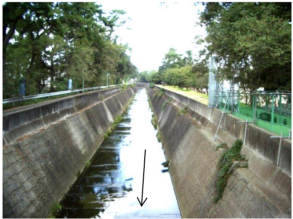
改修箇所写真(水路橋上流)
