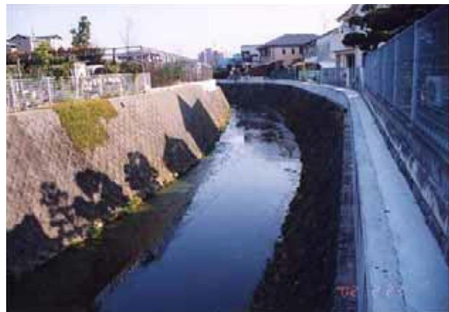
⑯ 昭和橋より下流を見る
