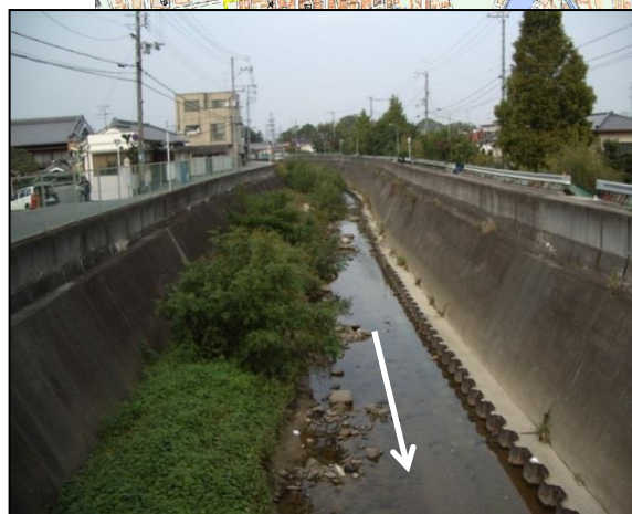
豊南橋から上流を見る
